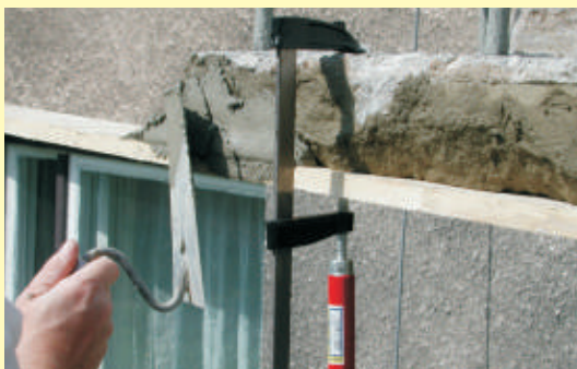
3. Wypełnianie ubytków/reprofilacja - Drobno- lub gruboziarnista zaprawa renowacyjna (Repol Saniermörtel Fein lub Grob).
