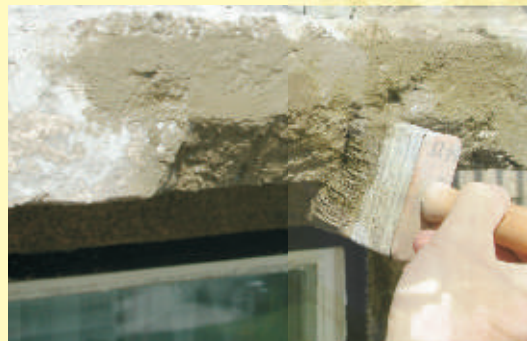
2. Utworzenie pomostu szczerwego - Szlam podkładowy Repol (Repol Haftschlämme).
