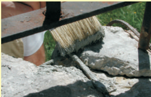
1. Antykorozyjna ochrona stali zbrojeniowej - Środek antykorozyjny do zbrojenia (Murexin Bewehrungsschutz Ferrosave).
